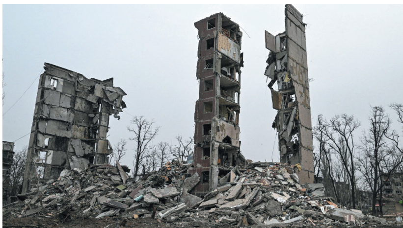
Обломки разрушенного в ходе боев здания квартала Юбилейный в Авдеевке. 22 февраля 2024 // Станислав Красильников / РИА Новости
